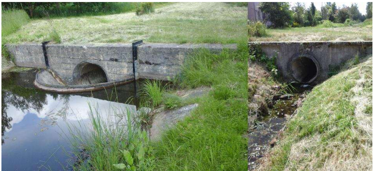
84 pav. Paaukštinta pralaida Kulpės ištekmėjime iš Rėkyvos ežero
